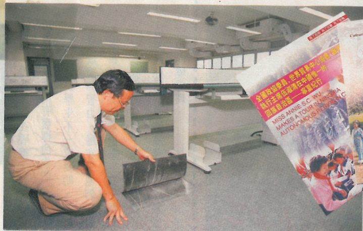
中華基金中學電腦室內，地板鋪了光纖，方便電腦線路的鋪設，是教育署二千年新設計的校舍的特色。
